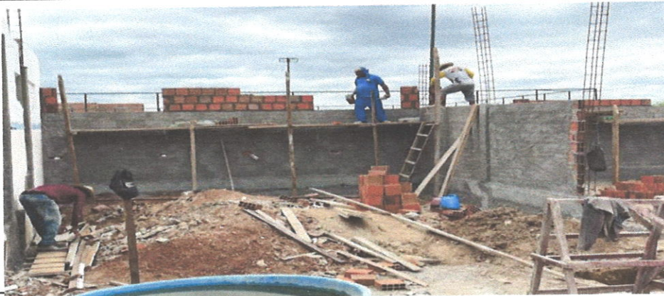
MONTAGEM DE FORMAS DOS PILARES
