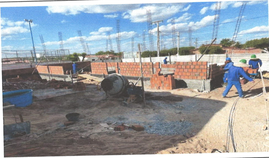
IMPERMEABILIZAÇÃO DE FUNDAÇÕES
