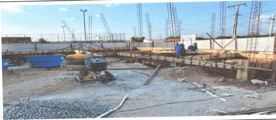
CONCRETAGEM DE VIGAS BALDRAME
