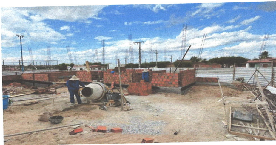
LEVANTE DE ALVENARIA DE BLOCO CERÂMICO
