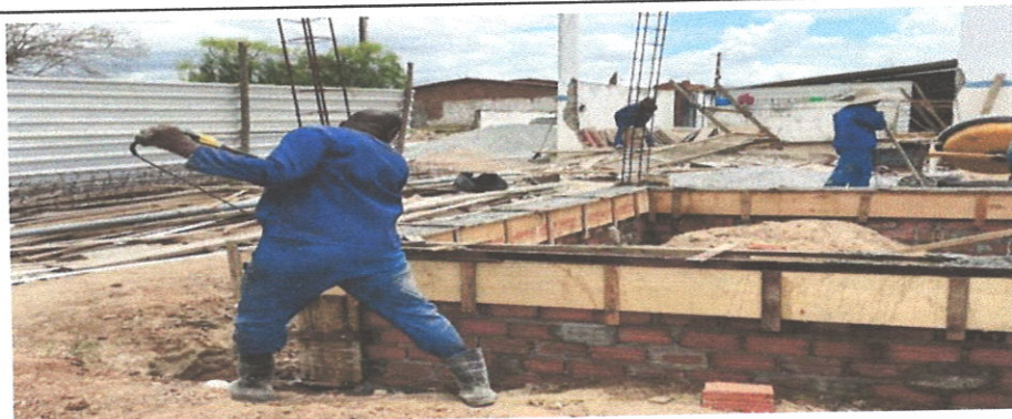
CONCRETAGEM DE VIGAS BALDRAME
