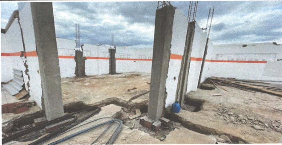
CONCRETAGEM DOS PILARES
