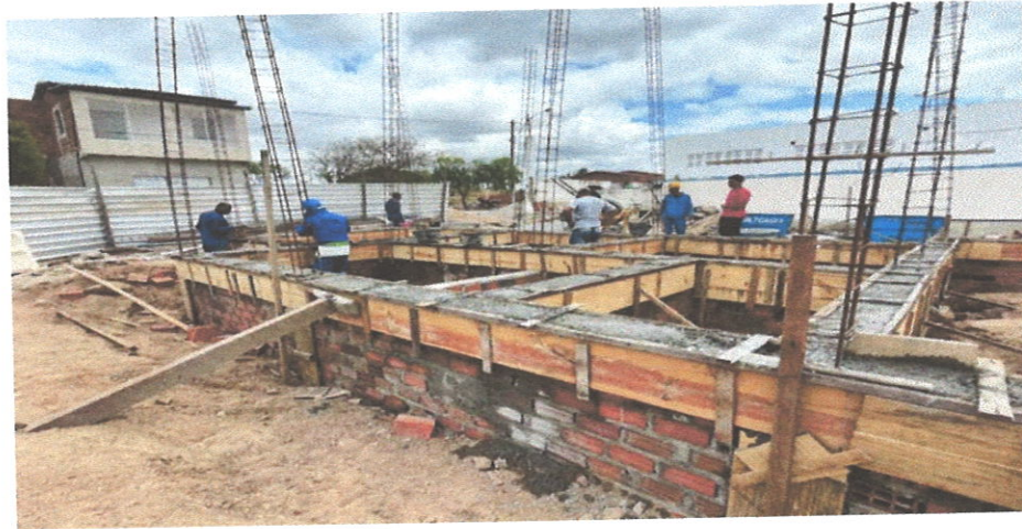
CONCRETAGEM DE VIGAS BALDRAME
