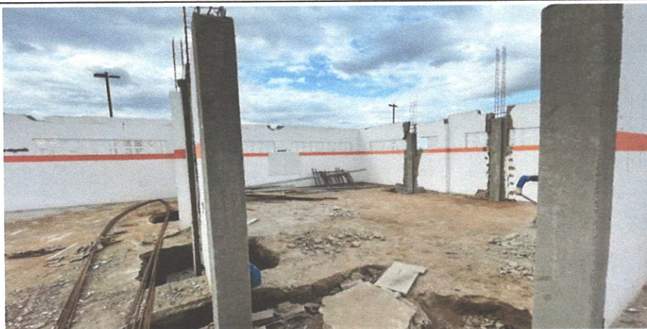
CONCRETAGEM DOS PILARES
