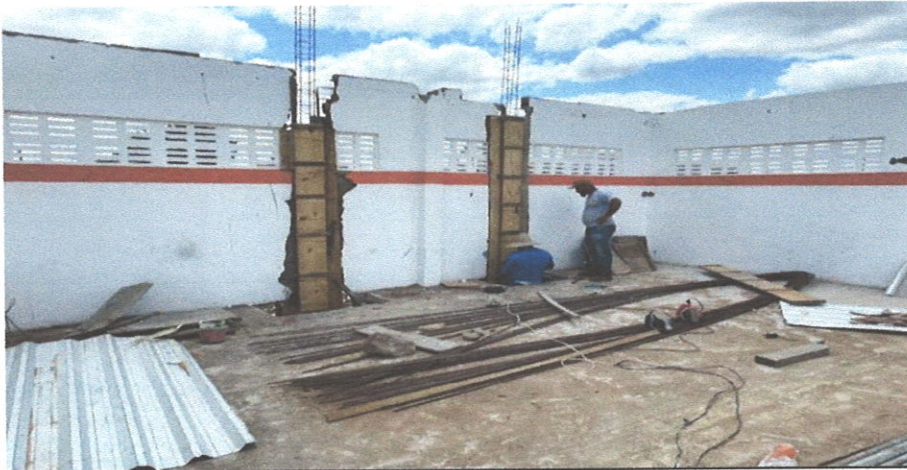
CONCRETAGEM DOS PILARES
