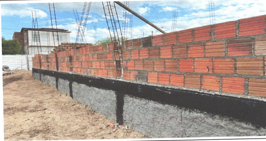
LEVANTE DE ALVENARIA DE BLOCO CERÂMICO
